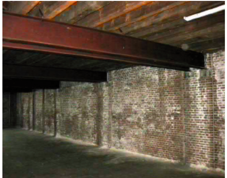
Image 4 : Plafond du 4e étage
